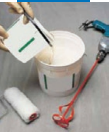
Смешивание компонента В с компонентом А
